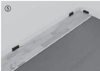
Pour commencer, poser les premiers éléments au coin droit de la pièce avec la languette côté mur et fixer à l'aide de cales biseautées en PE ou d'écarteurs (respecter un jeu de dilatation de 10 à 15 mm par rapport au mur).
