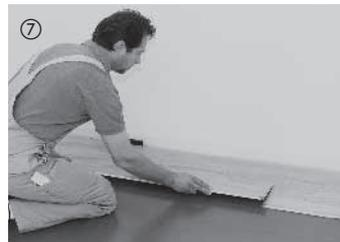
La deuxième rangée peut être commencée avec le reste de la première rangée (décalage des joints en bout d'élément d'au moins 50 cm). Ainsi on évite trop de chutes. Poser les autres lames les unes après les autres. Pour ce faire, les lames sont d'abord emboîtées sur la longueur sous l'effet d'une légère pression exercée dans la liaison.
