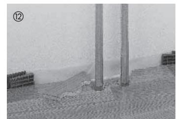
Découper et percer des ouvertures pour les tuyaux de chauffage sortant du sol (selon la taille des tuyaux et sans oublier le jeu de dilatation).
