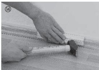
14 Une fois la pose terminée, il est impératif d'enlever les cales. Visser les plinthes (avec ou sans système à clips) – C'est terminé !
