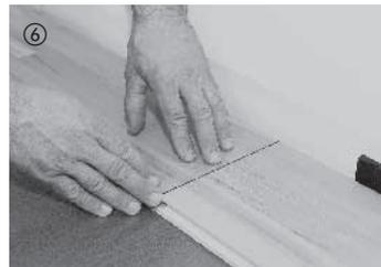
Les autres lames de la première rangée doivent être encliquetées dans la lame précédente. En appuyant légèrement sur le chant transversal, la lame s'enclenche dans la lame voisine. Veillez à respecter un alignement exact des lames. La dernière lame de la première rangée est coupée en respectant le jeu de dilatation de 10 à 15 mm par rapport au mur et emboîtée.
