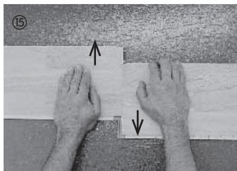
15 Déverrouillage Top Connect: les lames peuvent être glissées en parallèle.
