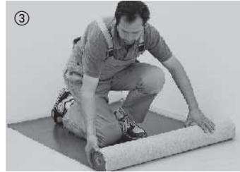
Pour l'isolation phonique et l'égalisation des petites aspérités, il convient de dérouler jusqu'aux bords une sous-couche acoustique confort de 2 mm d'épaisseur. D'autres sous-couches isolantes adaptées sont également disponibles parmi notre gamme d'accessoires. Le carton bitumé ne se prête pas à l'isolation phonique. **Tout parquet avec une sous-couche isolante contrecollée n'est pas compatible avec une pose collée en plein.**
